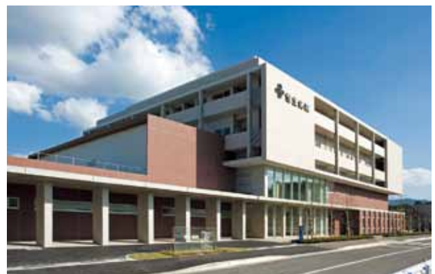
恒生病院外観
