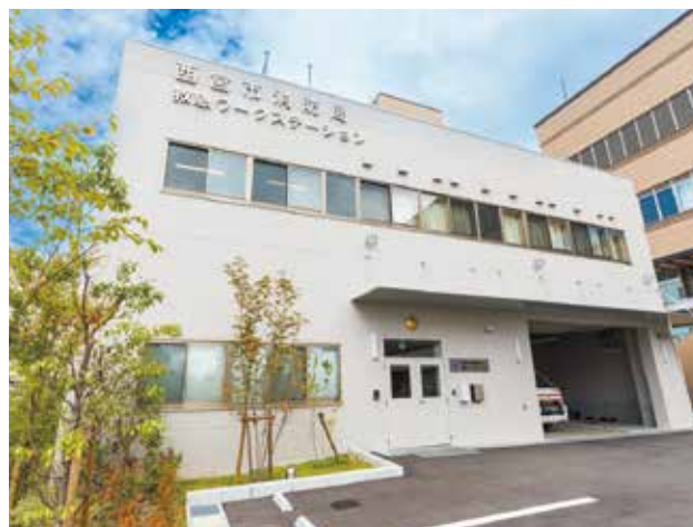
西宮市消防局救急ワークステーション
