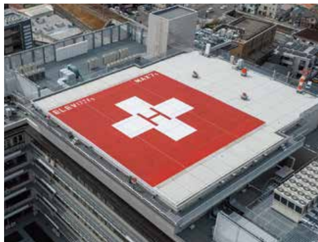
屋上ヘリポート
